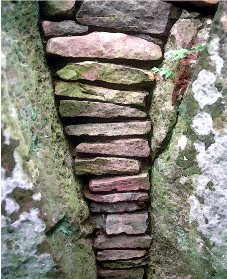
Kallmur mellan väggstenar.
